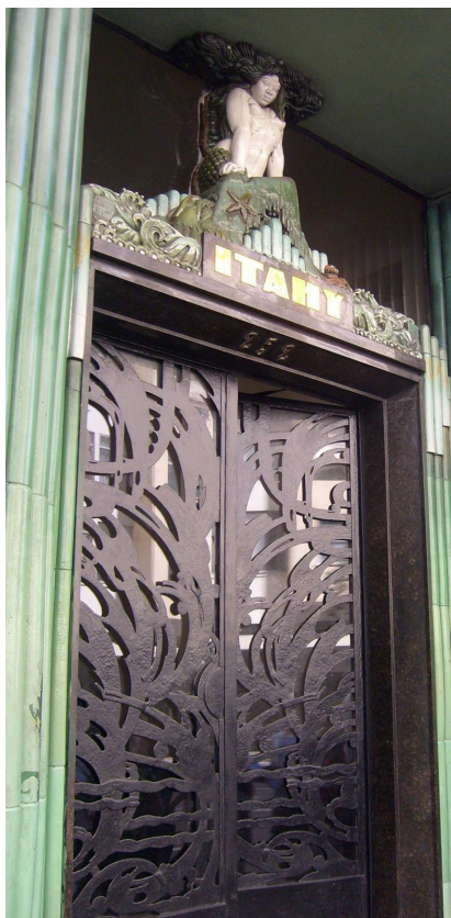
Fig. 6. Fotografia da portaria do edifício Itahy, Rio de Janeiro. Acervo do autor.
